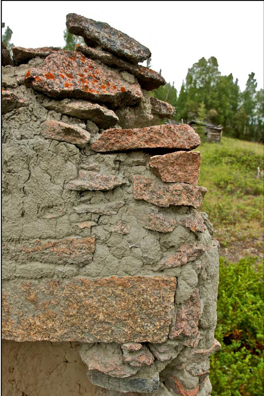
7.12 MORTAR & ROCK DETAIL – RH BACK
